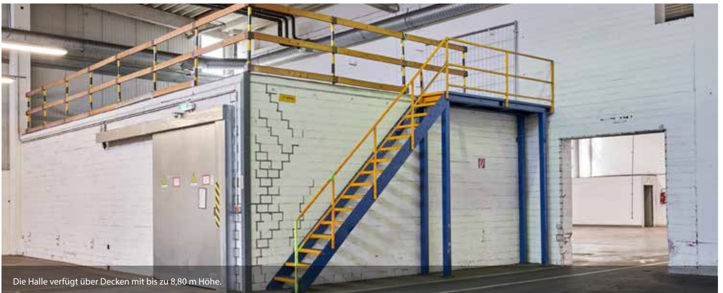
Mit einer Bodentraglast von ca. 10 t/m 2 ist die Fläche sehr belastbar.
